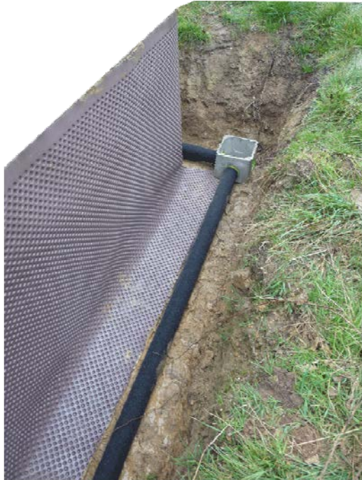
Figure 8 : Exemple d'installation du BâtiFIBRE®-SN4
